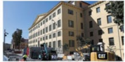
Le chantier de l'hôtel des polices, le 13 mars 2026. PHOTO JUSTINE HEDOUX
